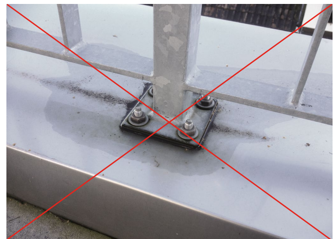
Abb. 7: Mangelhafte, unzulässige Ausführung
